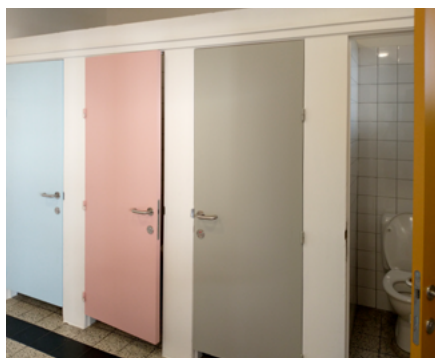
Situation après la rénovation (photo : école primaire Cade à Aartselaar)
