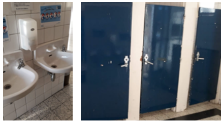
Situation avant la rénovation (photo : école primaire Cade à Aartselaar)
