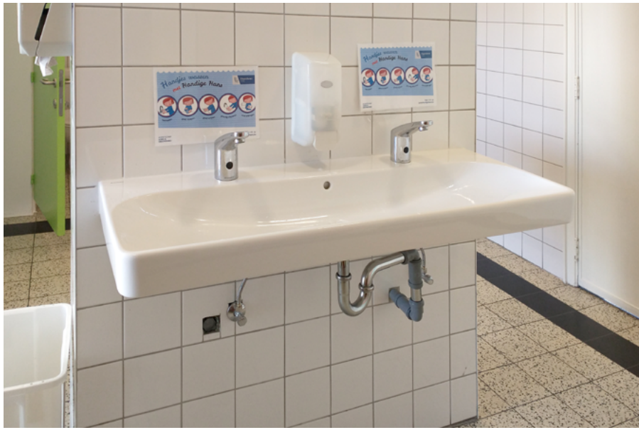
Situation après la rénovation (photo : école primaire Cade à Aartselaar)
