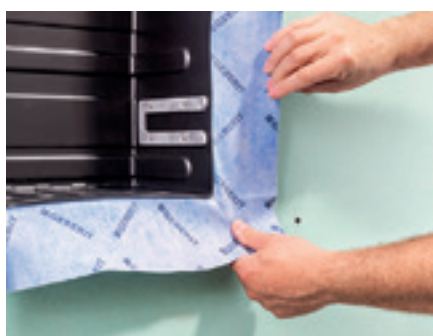
↑ La niche de rangement Geberit est équipée d'une feuille d'étanchéité montée en usine pour intégration dans l'étanchéité combinée et fait donc partie intégrante du système d'installation.
