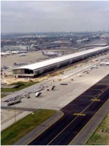
Aéroport Bruxelles National
